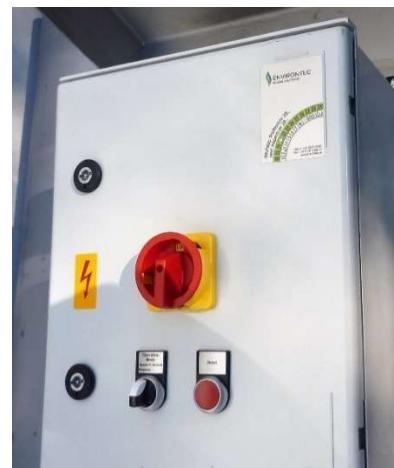
Abb 29: Plaque d'essai sur la chambre de contrôle
